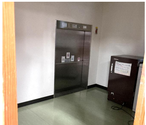
2階の保育室に給食を届けるために、エレベーターがついています。配膳用カートがそのまま入る大きさになっています。
